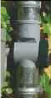
En installant **1 collecteur filtrant** (vendu séparément) (cf. page 43) sur le tuyau de descente, celui-ci fait office de trop-plein pour les citernes aériennes (écoulement des eaux filtrées dans la citerne et lorsque celle-ci est pleine l'eau repasse dans le filtre et s'évacue par le tuyau de descente).
