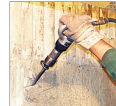
Décrépissage et décarrelage aisés
